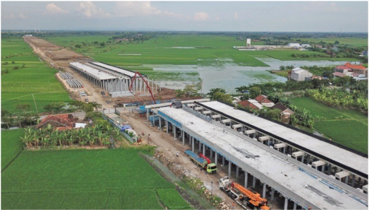
PROYEK STRATEGIS: Foto aerial proyek pembangunan tol Semarang-Demak seksi II di Kecamatan Karangtengah, Demak, Jawa Tengah, kemarin. Pembangunan tol sepanjang 27 kilometer yang dimulai awal 2020 itu merupakan Proyek Strategis Nasional (PSN) di Jawa Tengah dan diperkirakan rampung pada 2022 mendatang.
